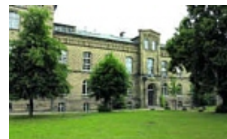
Hier soll ab August die neue Club of Rome-Schule einziehen: die ehemalige Heinrich-von-Stephan-Schule in Friedrichsort. Foto bjö
